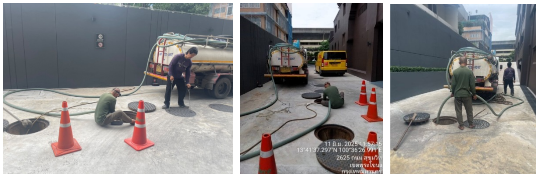
ภาพที่ 6-9 ดูดตะกอนส่วนเกินระบบบำบัดน้ำเสียและส่วนเกราะ
