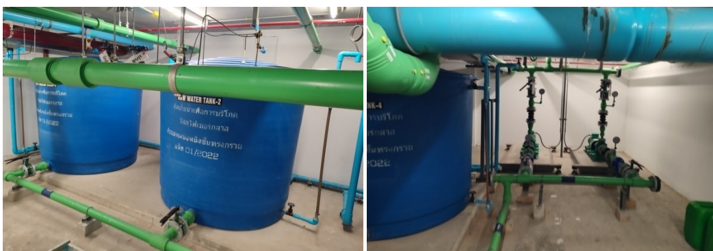
ภาพที่ 6-8 ตั้งสำรองน้ำใช้และระบบจ่ายน้ำประปา ไม่มีรอยรั่วซึม
