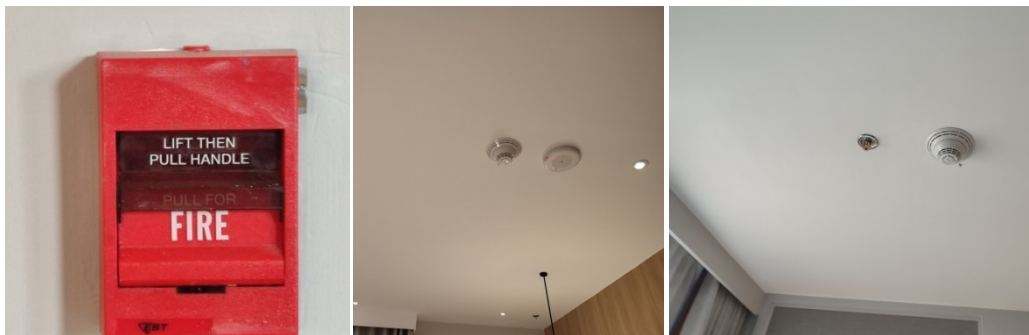
ภาพที่ 6-17 อุปกรณ์แจ้งเหตุเพลิงไหม้
