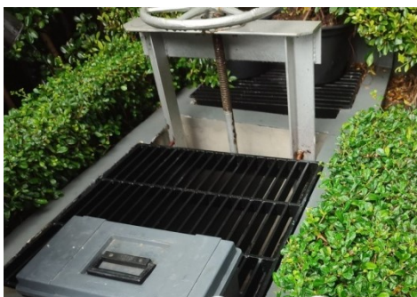
ภาพที่ 6-10 ตะแกรงดักขยะที่บ่อบำบัดน้ำเสียของโครงการ
